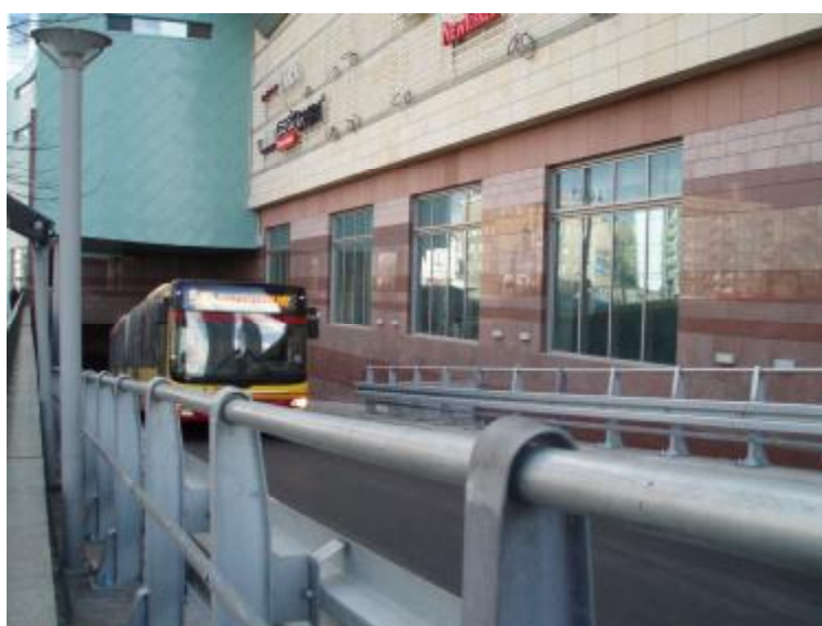
Rejon wjazdu i wyjazdu do Złotych Tarasów od strony al. Jana Pawła
