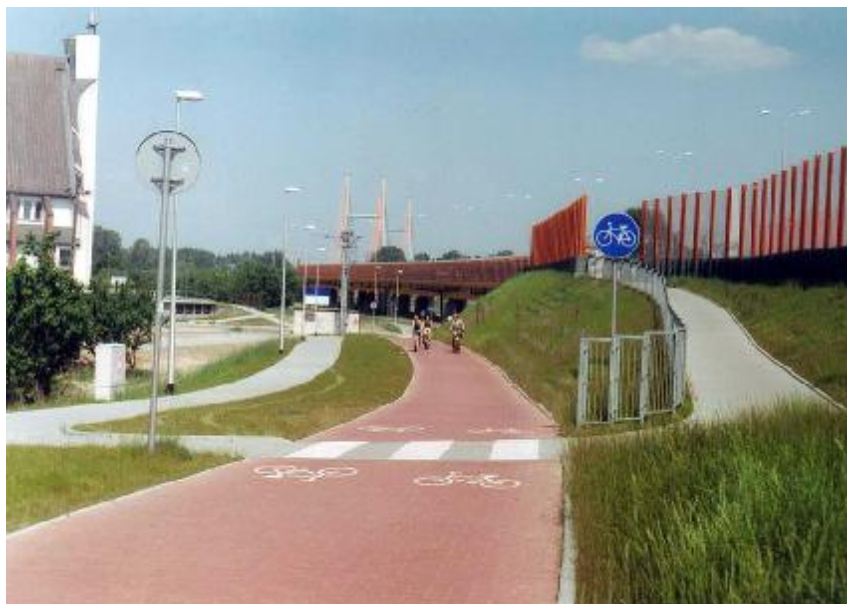
Fot. 1 – Ścieżka rowerowa wzdłuż Trasy Siekierkowskiej
