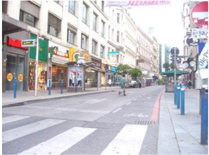
Fot. 8 Wiedeń – pas rowerowy pod prąd wyznaczony na jezdni prowadzącej ruch autobusowy
