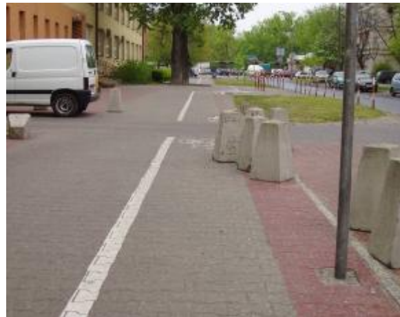
Fot. 2 Ul. Szanajcy w Warszawie. Przykład lekceważenia wyznaczenia drogi rowerowej. Słupki wyznaczające miejsca parkingowe ograniczają szerokość pasa przeznaczony dla rowerzystów
