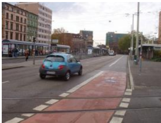
Fot. 6 Karlsruhe – Pas rowerowy wyznaczony na jezdni z zastosowaniem nawierzchni w kolorze czerwonym.
