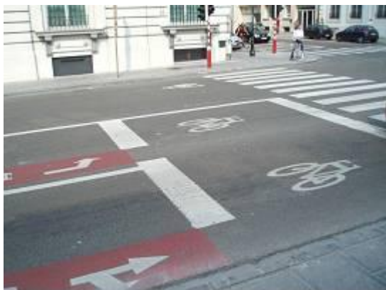
Fot. 5 Bruksela - Przykład pasów rowerowych wyznaczonych bezpośrednio na jezdni – widoczna segregacja ruchu przed skrzyżowaniem
