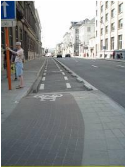
Fot. 7 Bruksela – pas rowerowy oddzielony od jezdni za pomocą separatora
