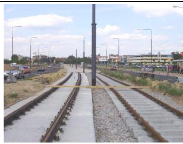
Fot.3. Przykład torowiska tramwajowego przygotowanego pod zabudowę nawierzchnią trawiastą
