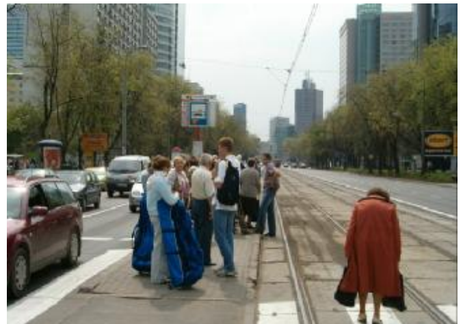
Fot. 3. Przystanek Hala Mirowska 04 . Wąska platforma przystankowa niewłaściwie chroni pasażerów przed ruchem pojazdów i nie „izoluje” od torowiska tramwajowego
