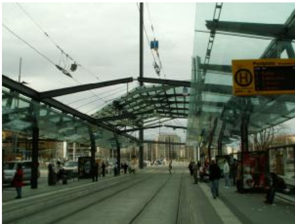
Fot. 3. Drezno – przykład pełnego zadaszenia platformy przystanku tramwajowego
