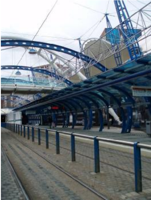
Fot. 5 Praga – trasa tramwajowa do Barrandova- przykład rozwiązania przystanku tramwajowego z pełnym zadaszeniem platformy
