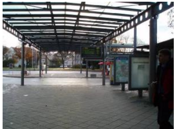
Fot. 4 Przykrycie nad przejściem dla pieszych w Baden-Baden łączące przystanek autobusowy z dworcem kolejowo-tramwajowym
