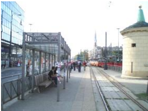
Fot. 1 Trasa Tramwajowa W-Z. Przystanek Metro Ratusz/Arsenał. Platforma przystankowa o długości 68m usytuowana za wyjściem z przejścia podziemnego do metra.
