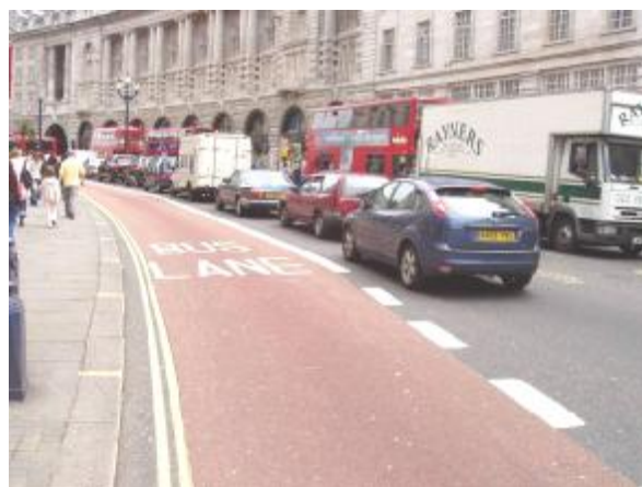
Fot. 2 Londyn - wydzielony pas autobusowy, wyodrębniony z jedni poprzez zastosowanie kolorowej nawierzchni
