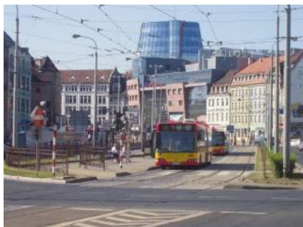
Fot. 1. Wrocław - wspólny pas tramwajowo-autobusowy na wydzielonym torowisku tramwajowym
